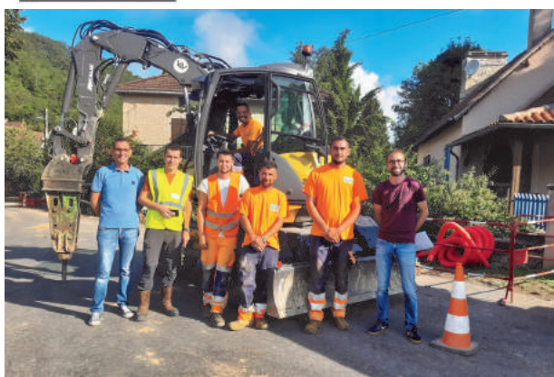
Travaux réalisés par les entreprises Montastier et Epeg Réseaux
