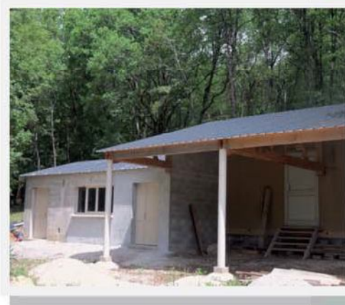
(Le relais de chasse en travaux)
